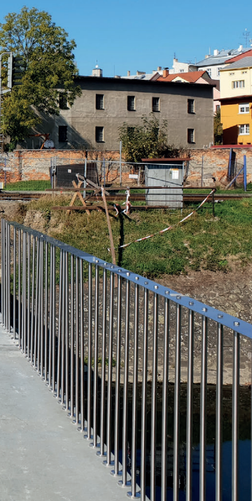
Předepjatá segmentová lávka v Příboře z UHPC vyvinutého v Kloknerově ústavu. Stav těsně před dokončením.
