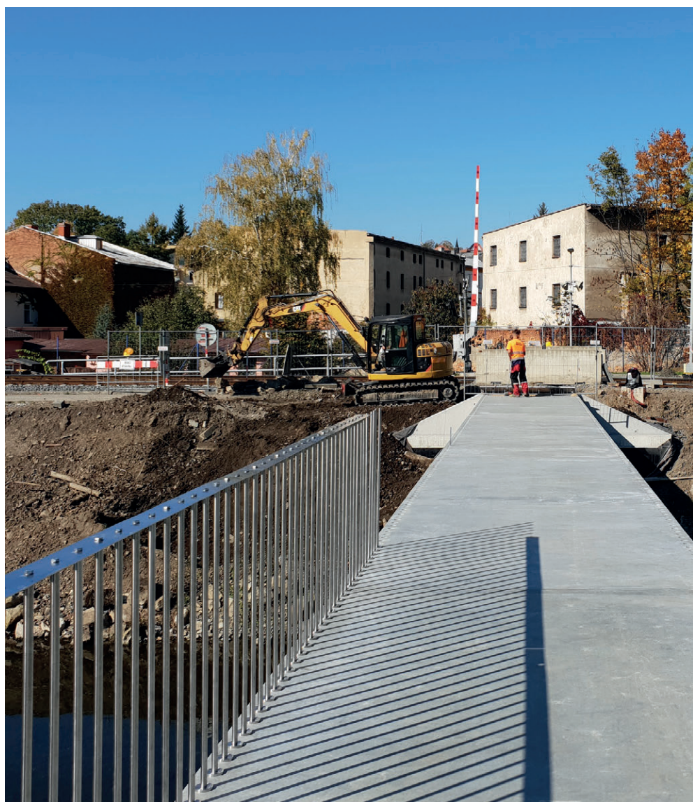
Unikátní dvojité zakřivená tenkostěnná lávka z UHPC. Dokončovaná instalace lávky v obci Vrapice, Kladno.
