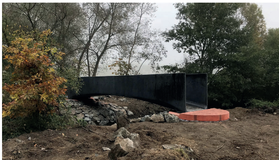
Unikátní dvojité zakřivená tenkostěnná lávka z UHPC. Dokončovaná instalace lávky v obci Vrapice, Kladno.
