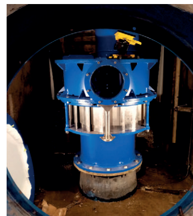
Průhled na instalované soustrojí prototypu ze strojovny do turbinové kašny
