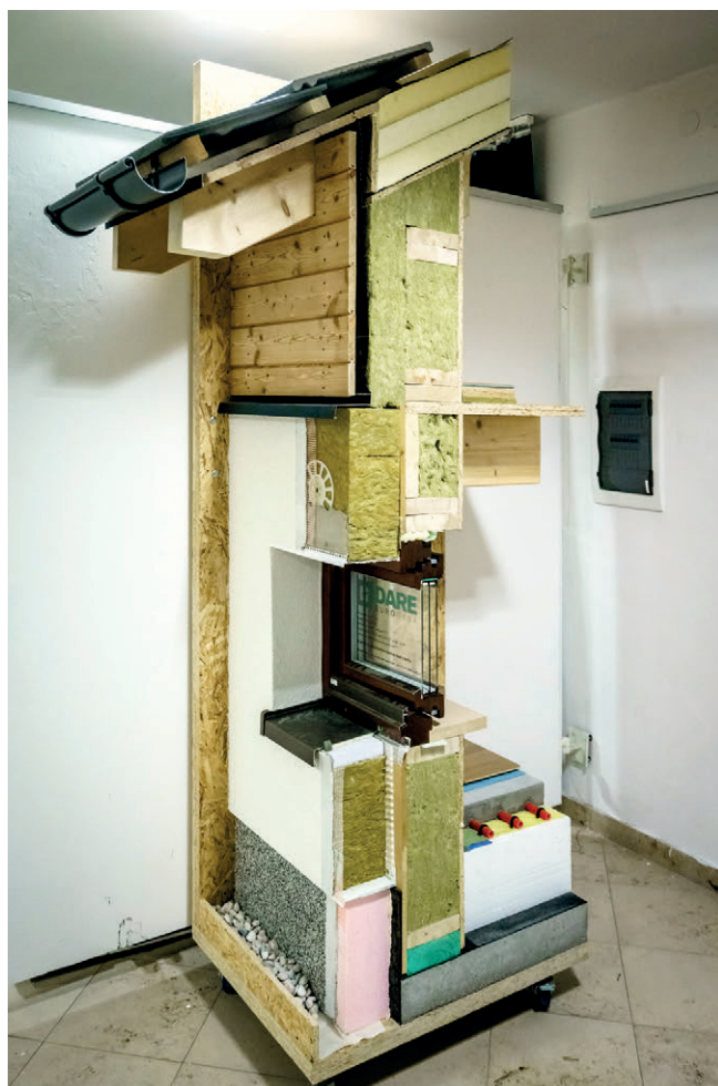
Modely stavebních konstrukcí používaných v rámci školení k budovám s téměř nulovou spotřebou energie.
