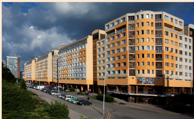
Teplo a chlad velkého panelového domu v pražských Stodůlkách řídí komplexní algoritmus. [ foto Lukáš Ferkl ]
