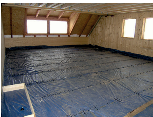
Stropní konstrukce před vybetonováním stropní desky / Zkušební těleso po požární zkoušce
