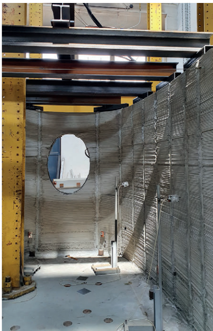
↖ PRVOK – pohled na stěnu během tisku, dům včetně roznášecích vahadel a vytištěná část domu
