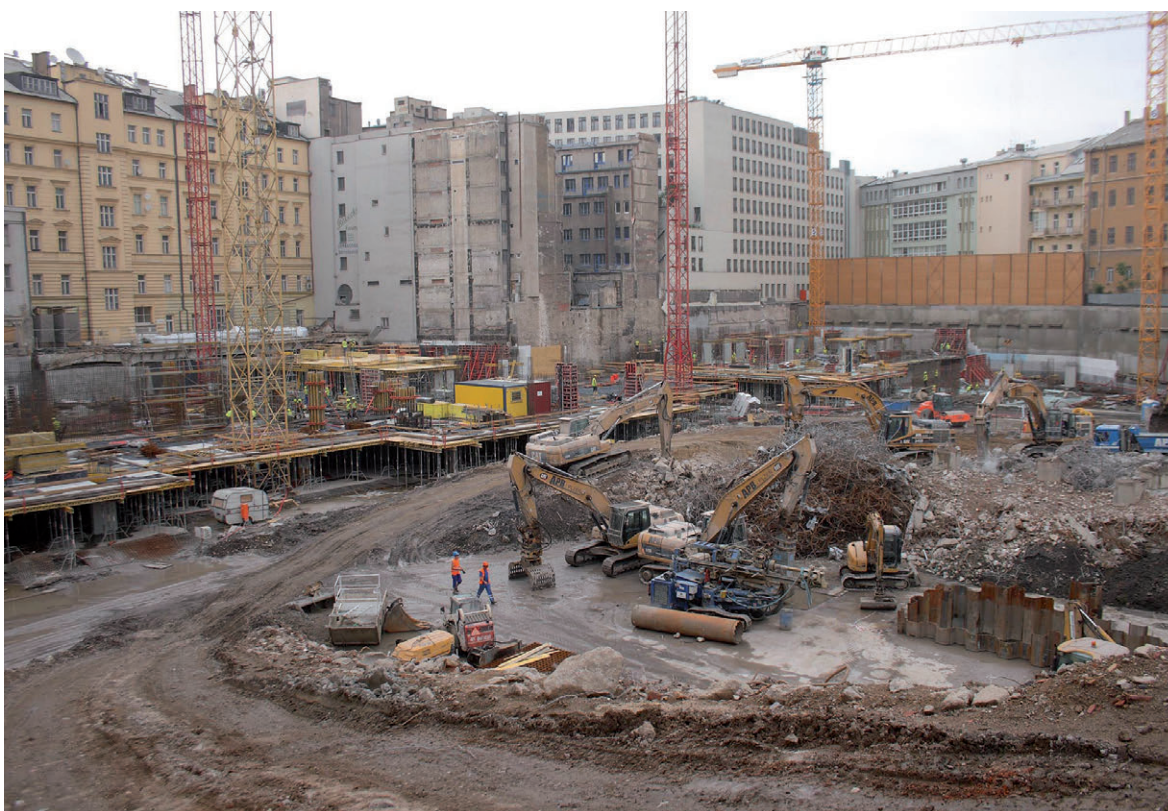
Dokončení demolice a zakládání stavby [ foto: APB Plzeň ]
